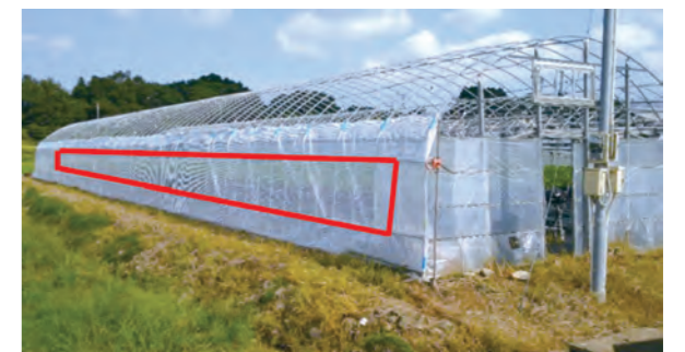
図15 光反射資材織り込みネット展開パイプハウス赤線で囲んだ部分に展開されている
