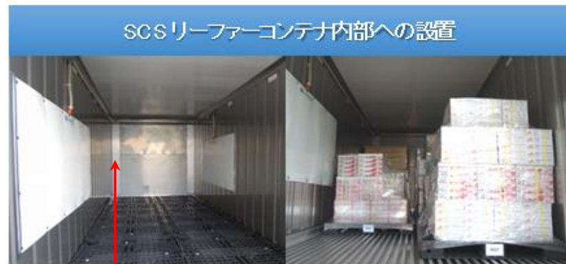
電源ユニット搭載
