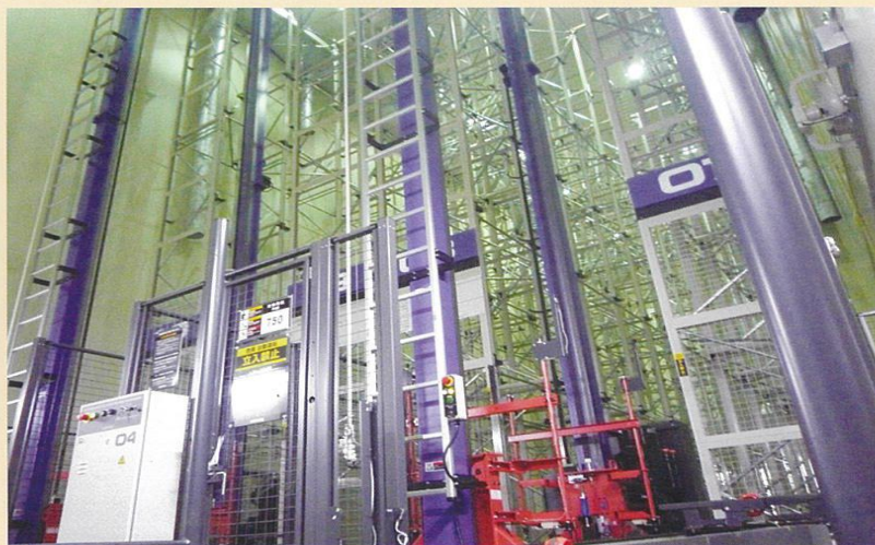
平成24年度「産地再生関連施設緊急整備事業」 (180 t の保温処理施設を増設)
