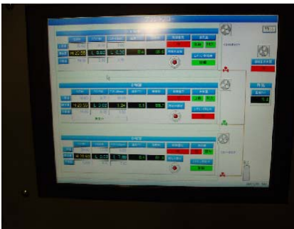
写真 7. プラントフローエチレン、二酸化炭素、酸素、湿度、温度の表示盤
