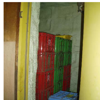
写真 3. 貯蔵庫の内部
